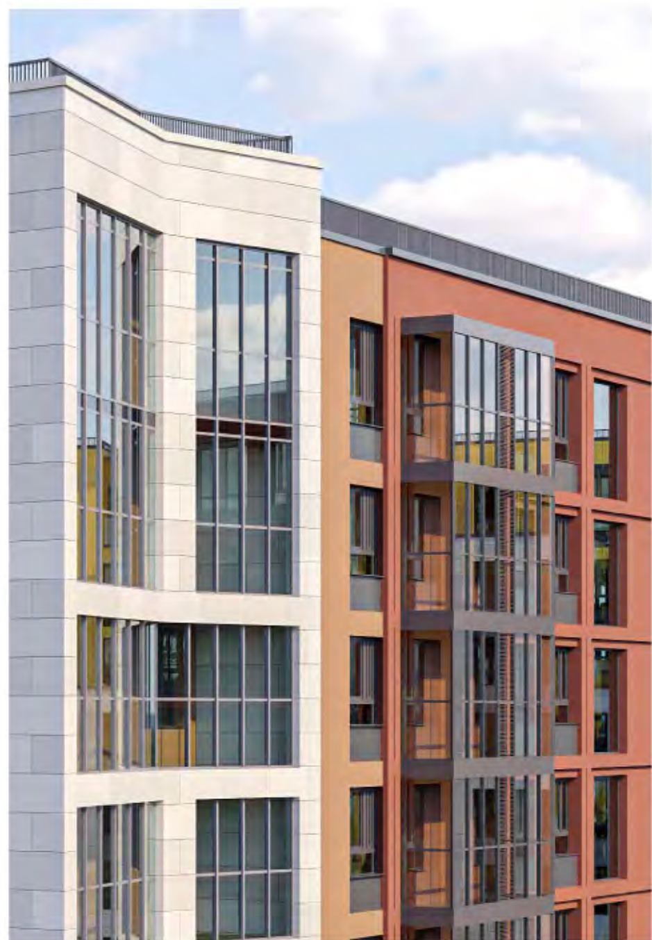
Остекленные балконы и лоджии
